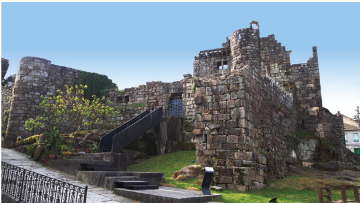
Castelo dos Sarmiento. Ribadavia Château des Sarmiento. Ribadavia
