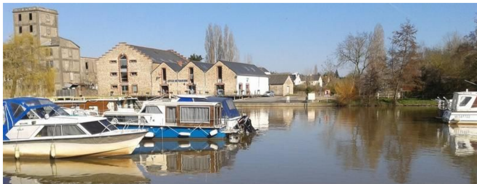
Port de plaisance de Nort-sur-Erdre.
