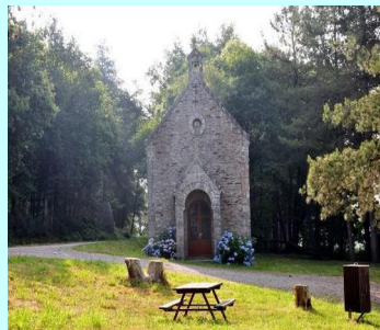
La chapelle du lieu-dit « le rocher de la vache »
