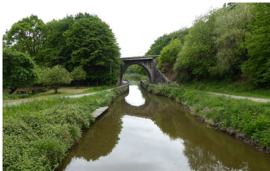
Vue du pont de Saint-Médard-sur-Ille.
