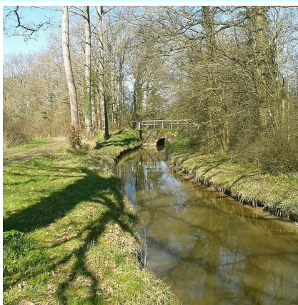
Rigole d'alimentation du Canal de Nantes à Brest avec un pont avec arcade.
