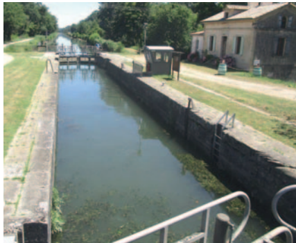
Ecluse de Bassanne (canal latéral à la Garonne, Gironde)
